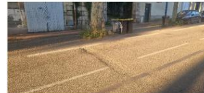
Un affaissement sur la largeur (28 Bd Berthelot)
